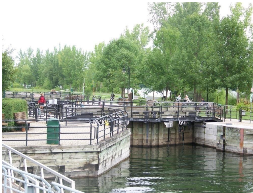
Les écluses du canal Chambly en 2008
